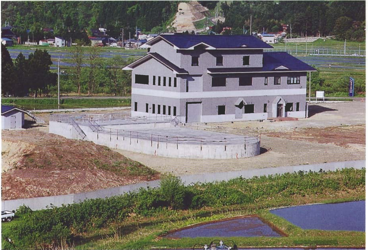
矢島町・矢島浄化センター (平成12年4月供用開始)
