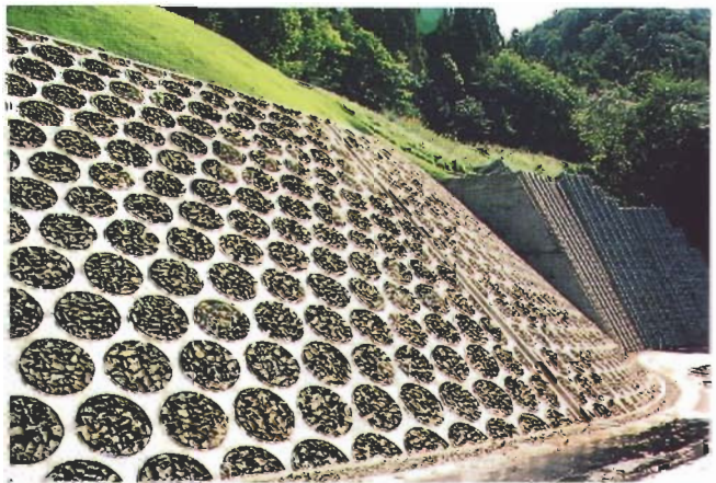
災害防除（県道田山花輪線 鹿角市）
