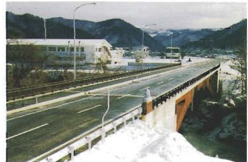
国道342号 東成瀬村田子内 (田子内バイパス)
