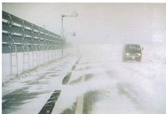
防雪柵（吹払式）（国道107号）
