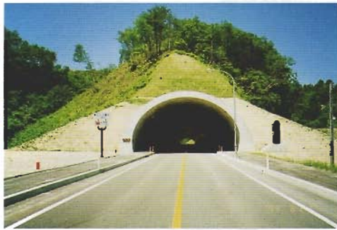
国道105号大内町・南外村矢立 (矢立トンネル)
