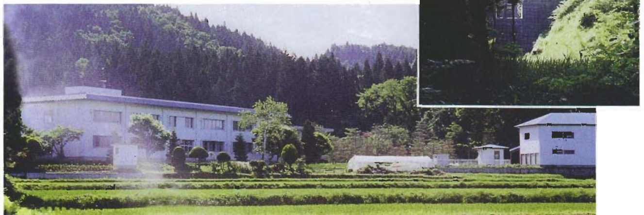
《災害弱者施設（病院）を保全する砂防堰堤 たつみ沢・大館市》
