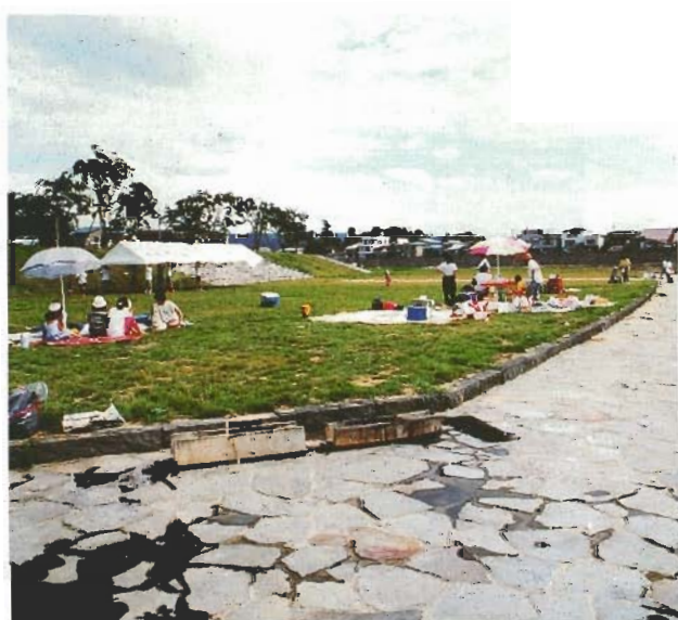
ふるさとの川整備事業 （横手川・横手市）
