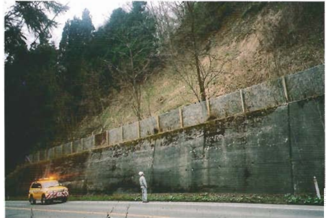
道路パトロール（国道105号）
