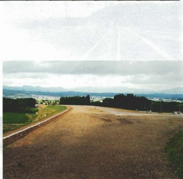
鷹巣川井堂川線・鷹巣町川口
