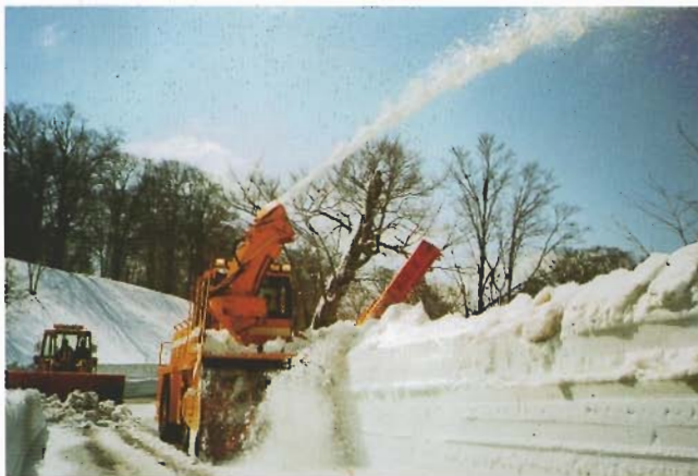
春山除雪（八幡平公園線 鹿角市）
