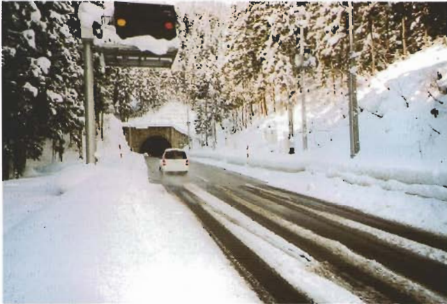
ロードヒーティング（国道285号 比内町）
