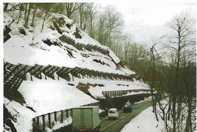
雪崩予防柵（国道103号 鹿角市）
