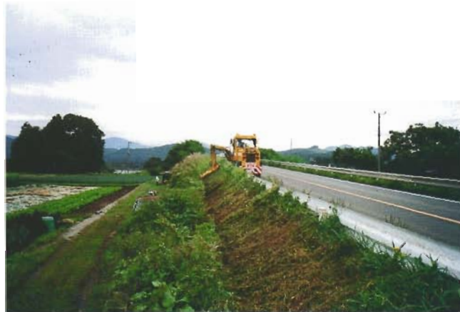
除草作業（国道103号 大館市）
