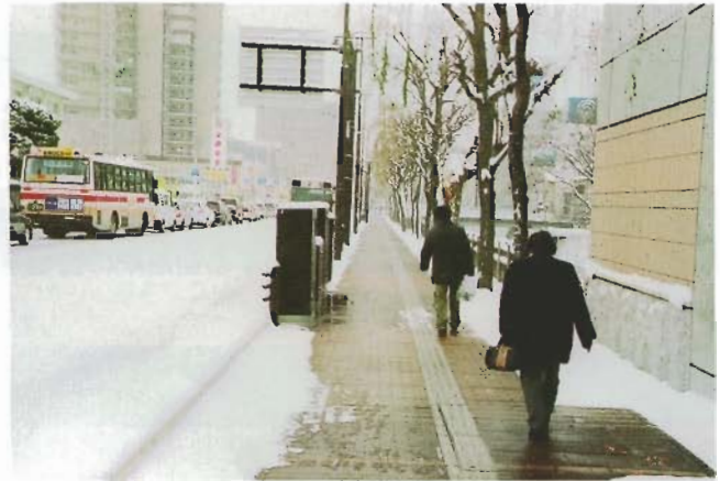
歩道無散水施設（一般県道 土崎港秋田線 秋田市）
