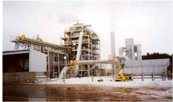
能代バイオマス発電所
