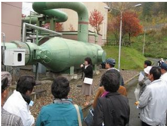
地熱発電所等見学会の様子
