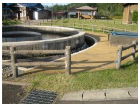
美郷町：七滝農業用水施設 (舗装：有機系舗装材)
