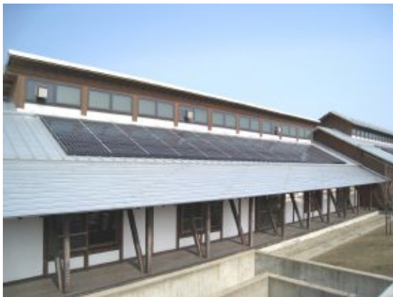
太陽光発電システム
