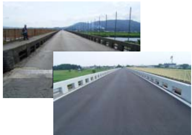
県単道路補修事業（(主)大曲大森羽後線 大曲橋）
