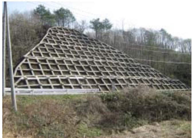
国道道路災害防除事業（R285 大館市板戸）
