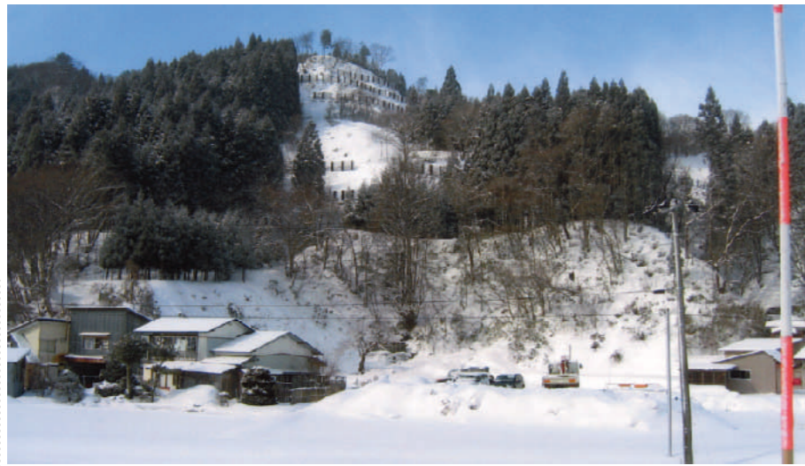
藤里町坊中の雪崩対策事業
