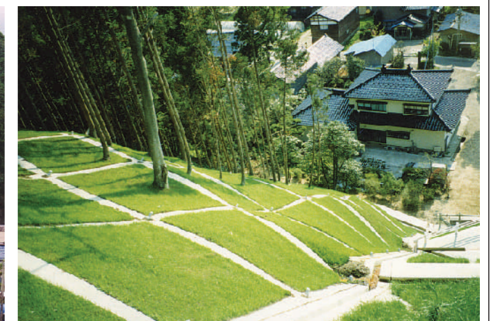
由利本荘市蒲田の急傾斜地崩壊対策事業
