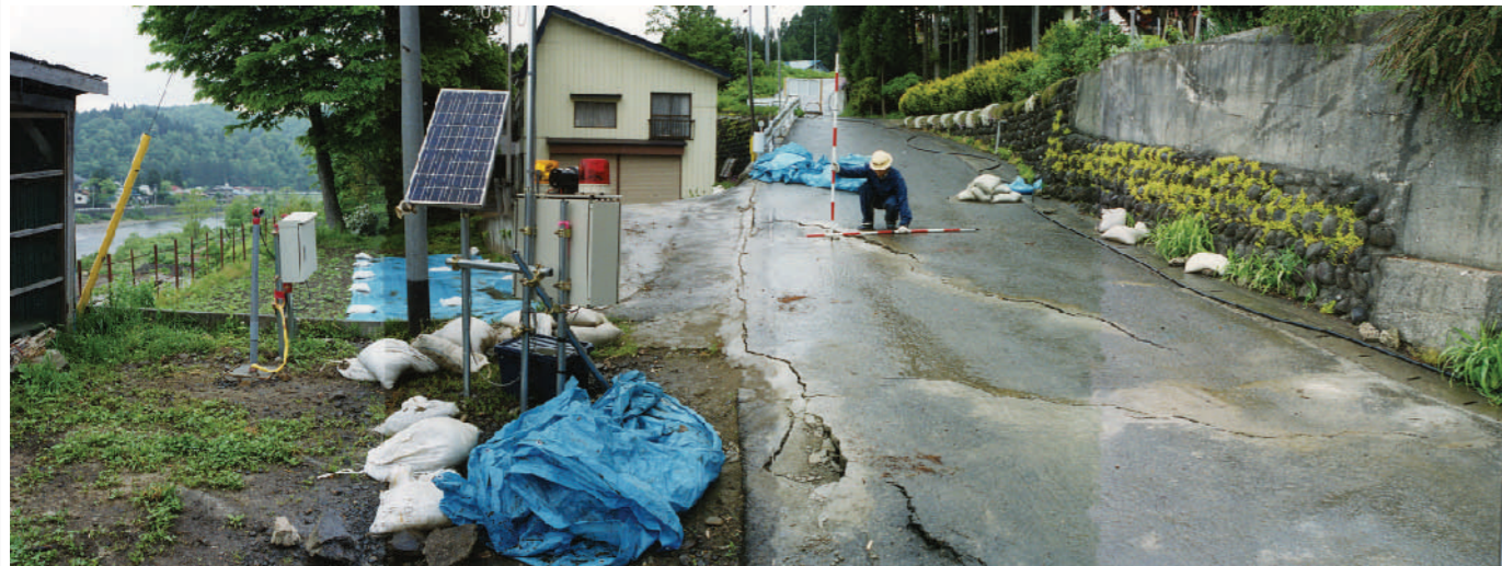
北秋田市森吉下前田の被災状況
