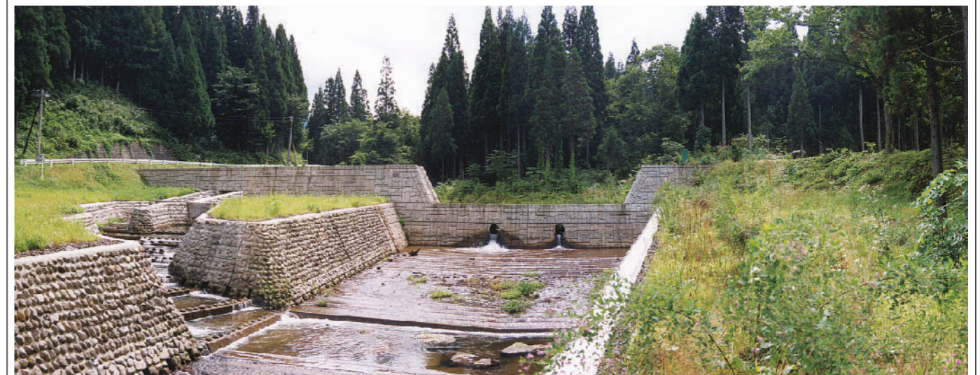
湯沢市桑崎地内/御返事川床固工(魚道設置)
