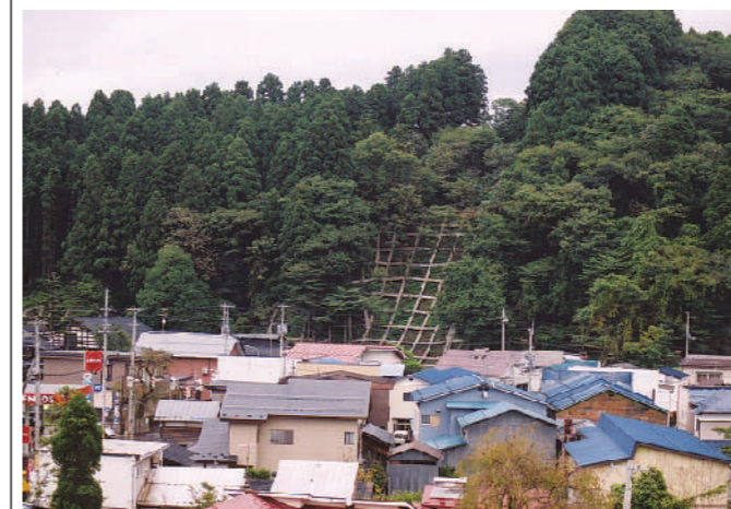
仙北市角館町田町下丁の急傾斜地崩壊対策事業
