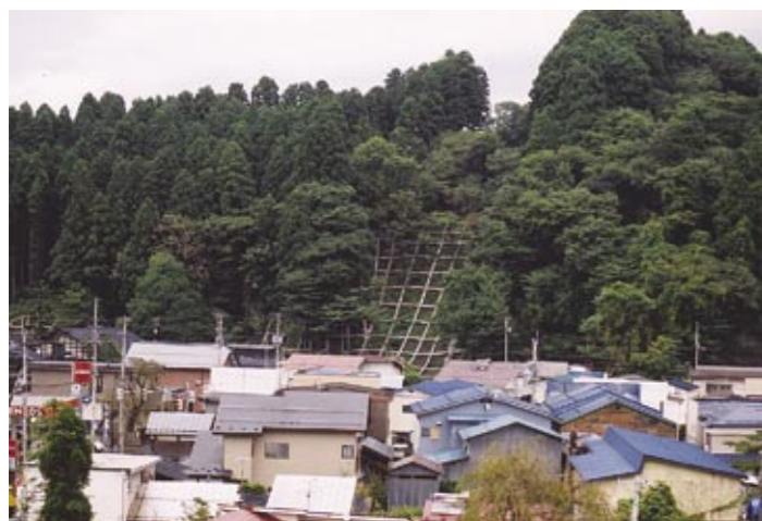
角館町田町下丁の急傾斜地崩壊対策事業
