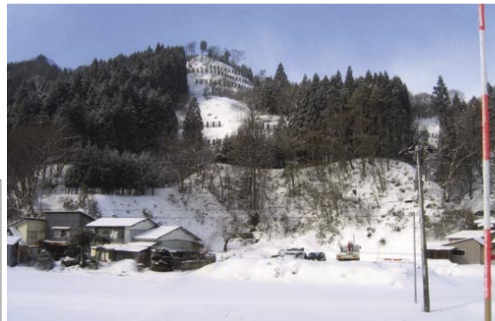
藤里町坊中の雪崩対策事業
