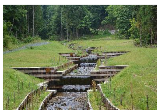
木製治山ダム工（オールウッド）
