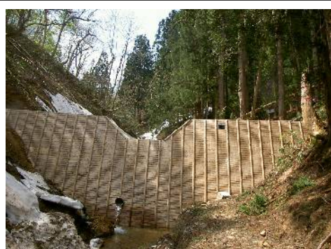
木製残存型柵を使用した治山ダム工
