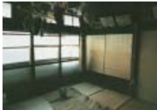
居間となりの次の間 改修前は使用されてい なかった
