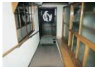
既存の物置を改修し土間縁へ出られるスロープをつかった。右側収納スペース
