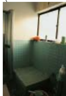
浴室はタイル貼りで入 口が狭く、床の段差も 大きい
