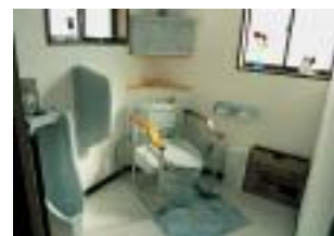
古いトイレとボイラスペースを一つにして広さを確保
