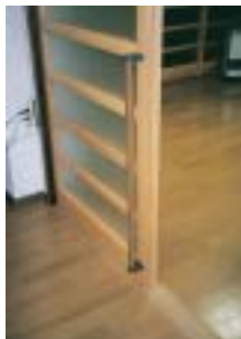
茶の間と食堂間仕切段差解消及び建具取手（どの位置でも引ける）
