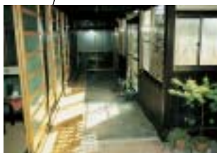
玄関～土間縁間仕切を撤去
