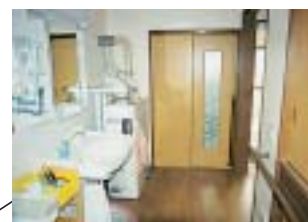
洗面台は昇降機能付洗面台を採用。正面はトイレ入口
