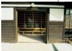
玄関内部 出入口敷居を撤去 車イスでもスムーズに入出りできる
