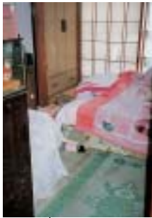
北西の角の 既存寝室
