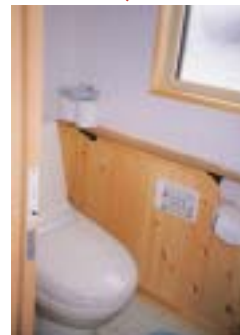
改修後 トイレ 内部（水洗化）
