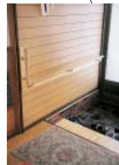
玄関ホール 踏み台及び手すり新設
