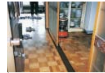
ローカ～台所 間仕切敷居段差あり
