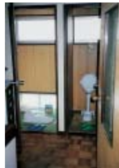
トイレ 床の段差解消と、水洗化したい
