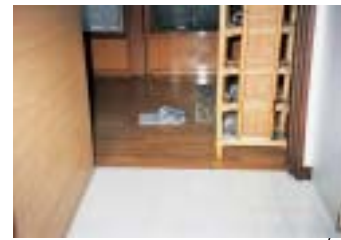
ローカ～脱衣室 床敷居撤去
