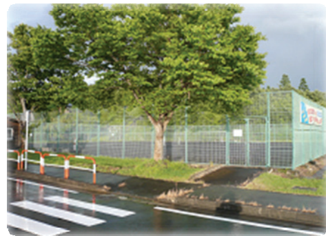
○破損しているテニスコート(9月10日監査人撮影)
