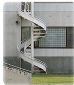
○非常用設備 (9月10日監査人撮影)
