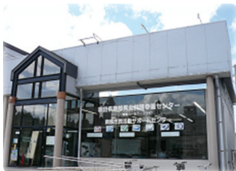
○施設正面(9月11日監査人撮影)
