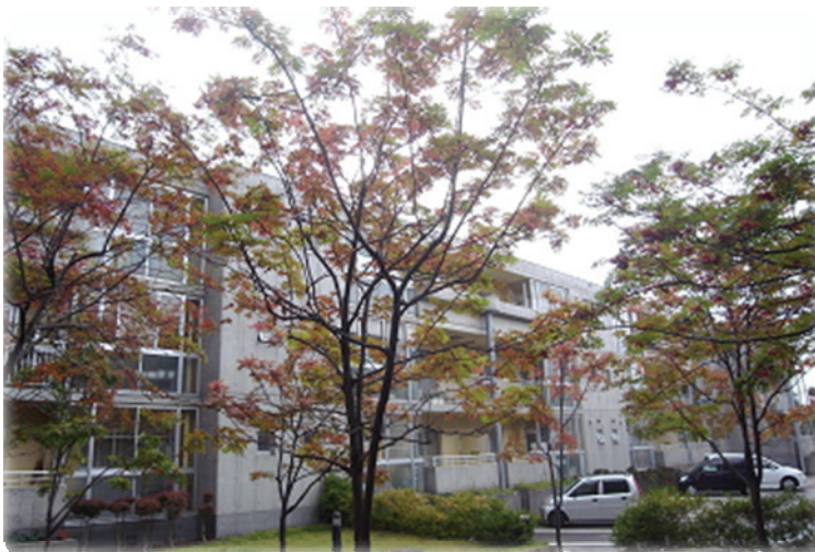
○県営旭南住宅(10月16日監査人撮影)
