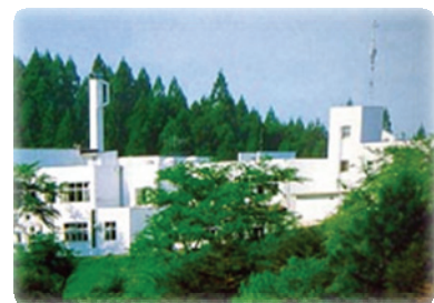
○施設全景(秋田県ウェブサイトより)
